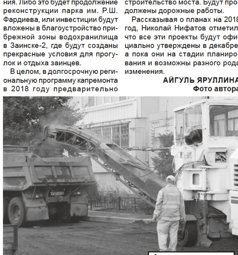
Фрезерование дорог
