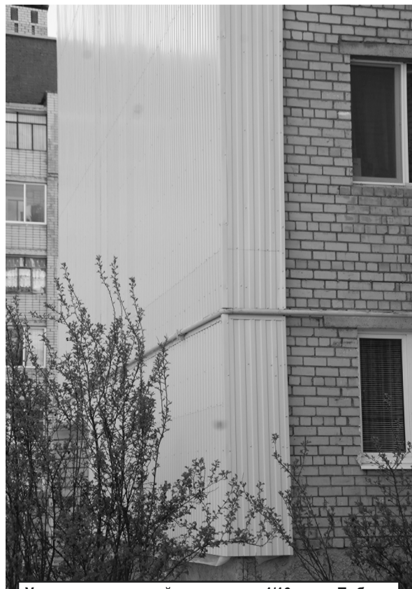
Утепление торцевой стены дома 1/16 по пр.Победы
