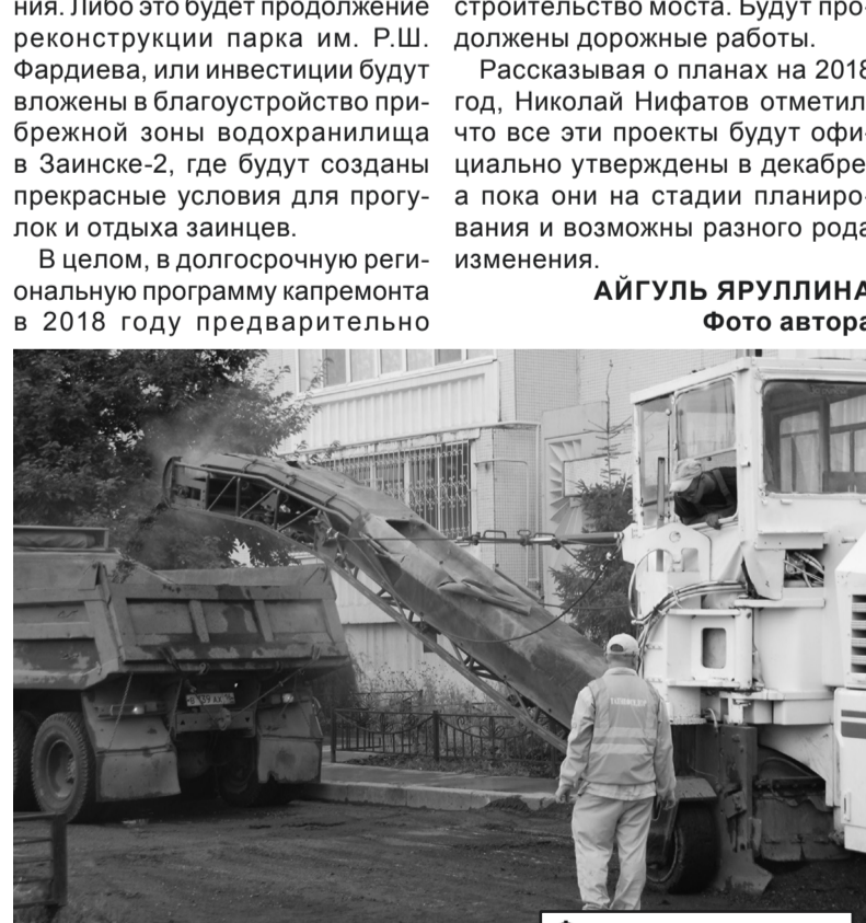
Фрезерование дорог
