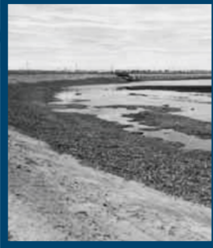
1_Термоэрозионное разрушение тела насыпки
