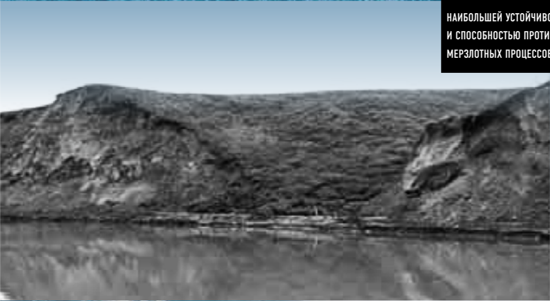
2_Заболачивание придорожной территории 3_Термоабразионное разрушение берегового участка-насыпки
