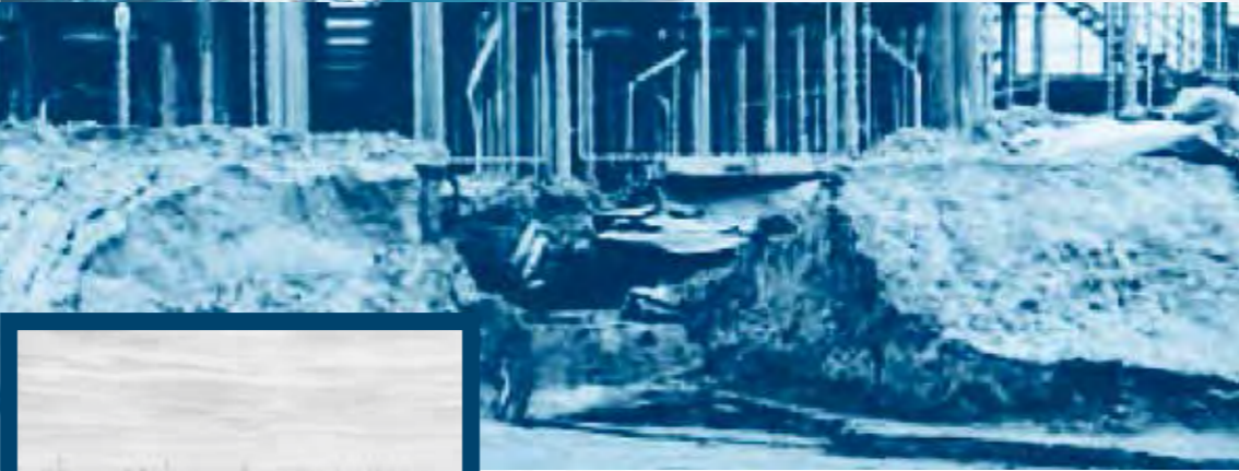
1_Термоэрозионное разрушение тела насыпки
