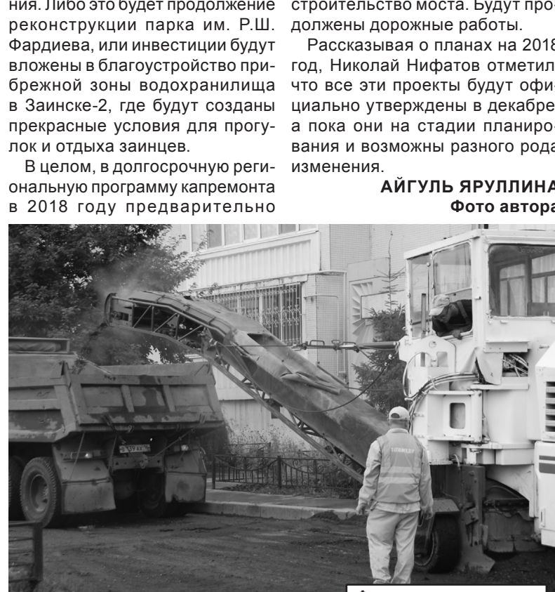
Фрезерование дорог
